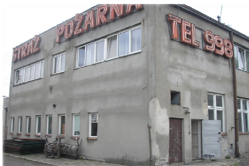
Budynek strażnicy JRG Nr 4 od strony ul. Dąbrowskiego
