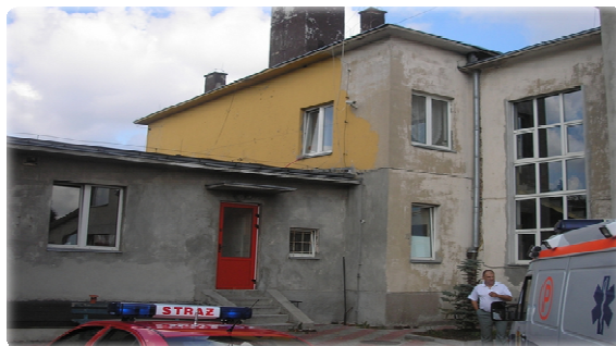
Budynek strażnicy JRG Nr 10 od strony placu wewnętrznego
