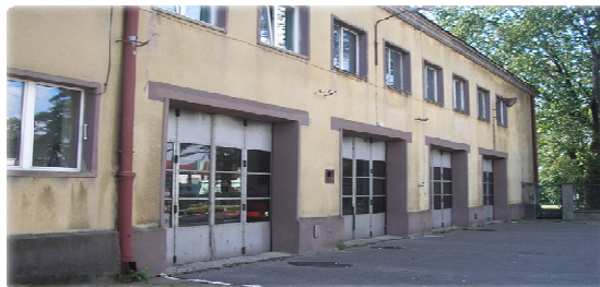
Wygląd budynku strażnicy JRG Nr 9 od strony ul. Czołgistów
