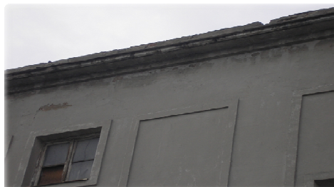
Dach budynku strażnicy JRG Nr 2
